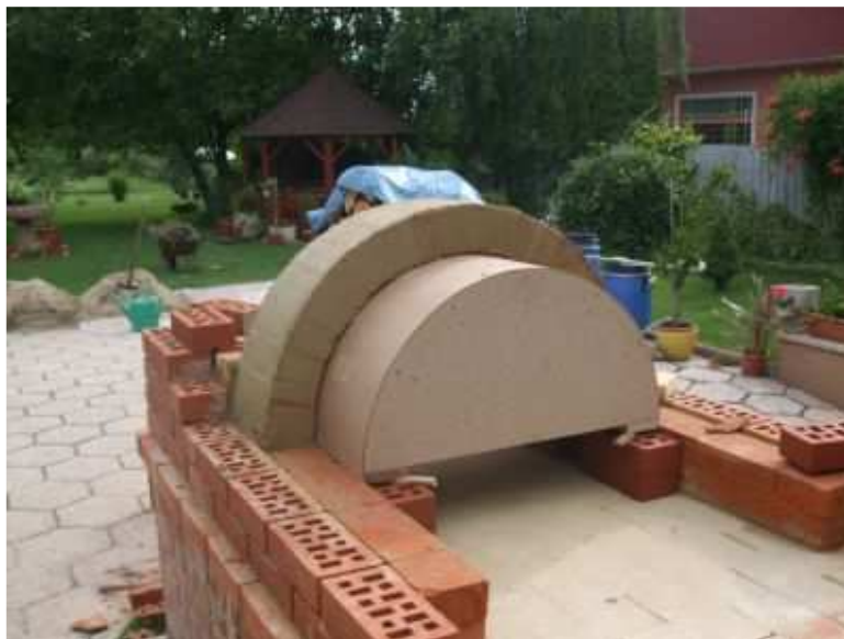
Futóra falazott donga két soremeléssel, kötés nélkül falazva.
