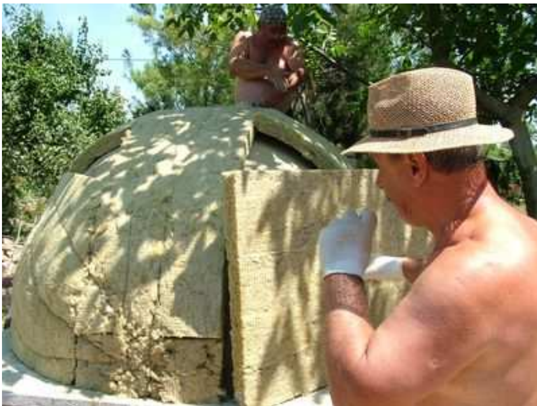
Hőtükrös- és sima kőzetgyapot szigetelés, valamint a puhább és szilárdabb felrakásának a bemutatása
